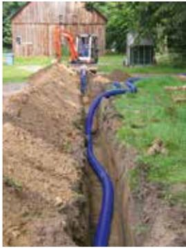
Die Microflex-Rohrleitungen werden kanalfrei in der Erde verlegt. Es ist besonders praktisch, wenn die ausgehobene Erde neben dem Gelände deponiert wird. Von der freien Seite aus werden die folgenden Schritte ausgeführt:
